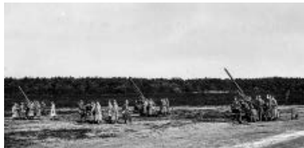
Een batterij Vickers-luchtdoelkanonnen van 7,5 tI in stelling, met in de voorgrond de commandant bij het vuurleidingstoestel. Dankzij het Fonds Zuiderzeewerken kon in 1934 een eerste aanschaf van dit moderne luchtdoelgeschut plaatsvinden. Later volgden meer batterijen via het Defensiefonds uit 1936. Foto: NIMH
