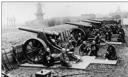
Batterij 12 Lang Staal tijdens een gasalarmoefening. De stukken staan in Gorinchem in stelling. (NIMH Den Haag)
