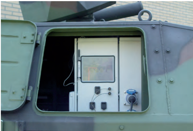
Schakelkast display / schakelkast
